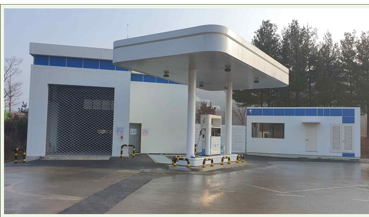
춘천휴게소(부산방향) 수소충전소 전경
